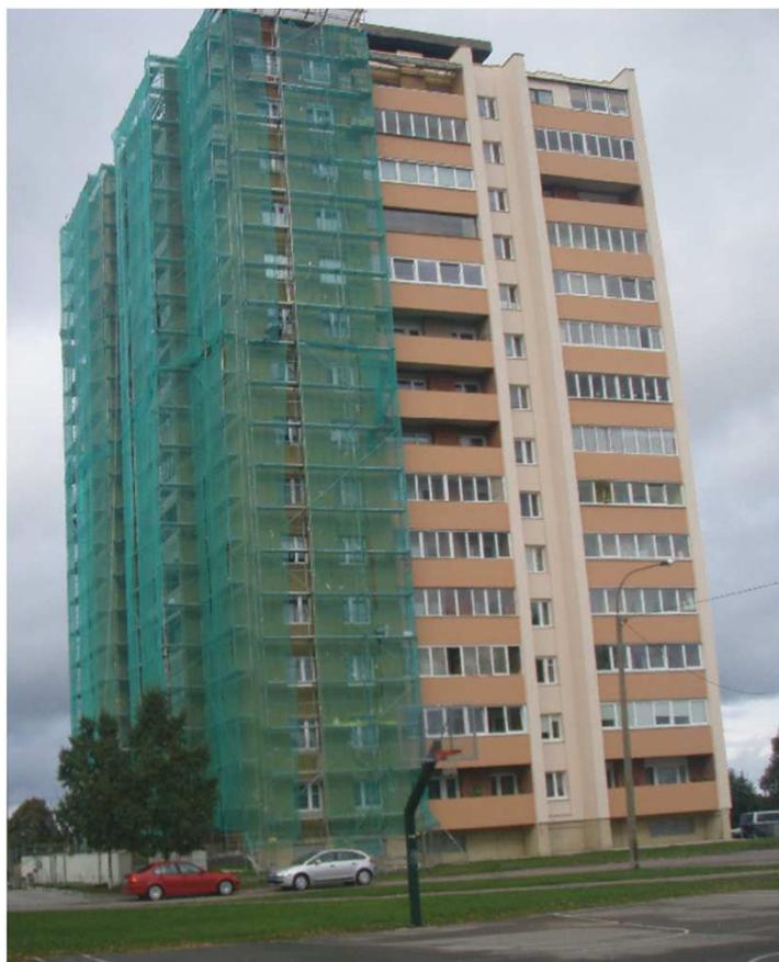
После утепления крыши, фасада и подвала потребление тепла снижается 1,7 раза или на 40%.
