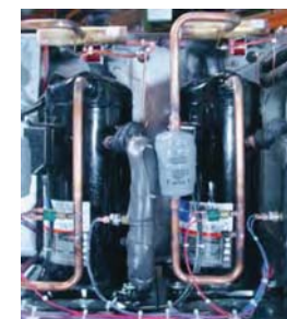
Спиральные компрессоры Copeland (с двумя цепями на моделях на 8 тонн и выше)
