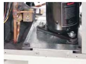
Эксклюзивная двойная изоляция компрессора уменьшает вибрацию компрессора и улучшает общие шумовые характеристики
